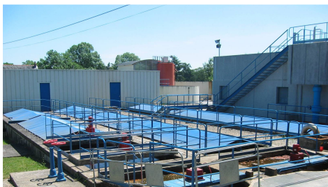
Usine d'eau potable de « Mirwault »
