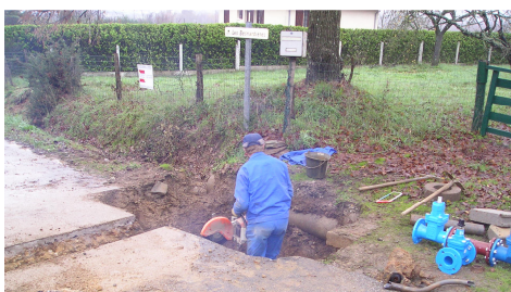
Raccordement de conduite à Azé
